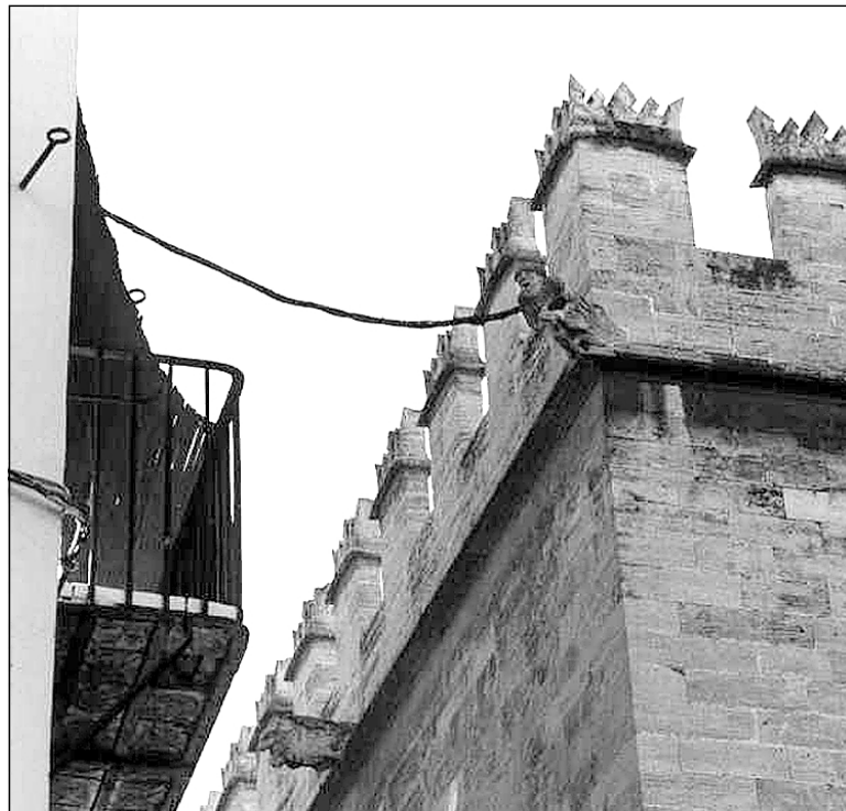
Uno de los cables, en la calle la Lonja.
