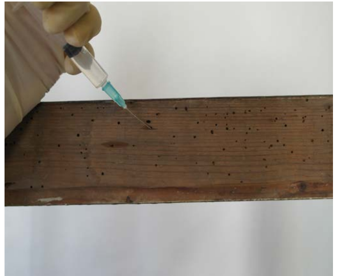
Fig. 43 - Consolidación de la madera
