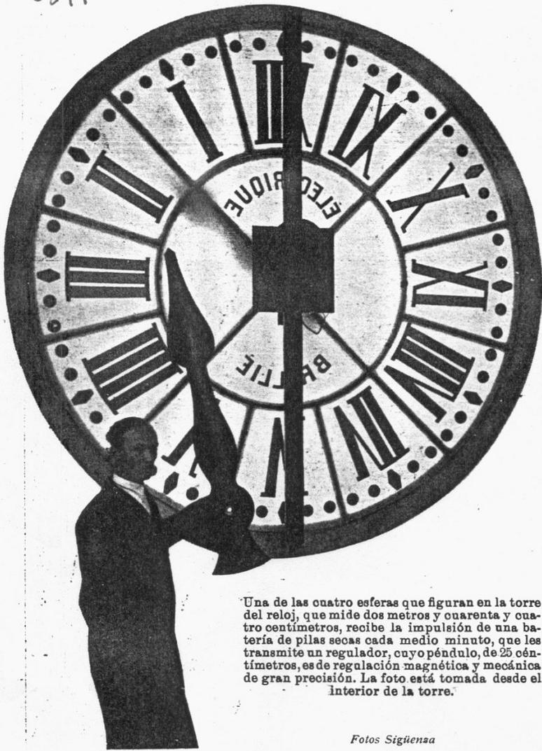
Una de las cuatro esferas que figuran en la torre del reloj, que mide dos metros y cuarenta y cuatro centímetros, recibe la impulsión de una batería de pilas secas cada medio minuto, que les transmite un regulador, cuyo péndulo, de 25 centímetros, es de regulación magnética y mecánica de gran precisión. La foto está tomada desde el interior de la torre.
