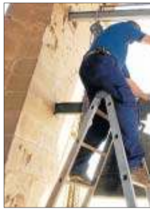
Desmuntatge. L'operació va consistir a desmuntar la finestra i despenjar la campana.
