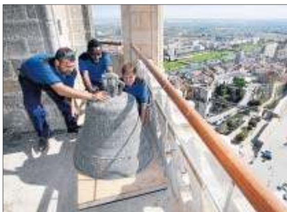
Plataforma. Els operaris van situar la campana sobre una plataforma per desplaçar-la amb la grua.
