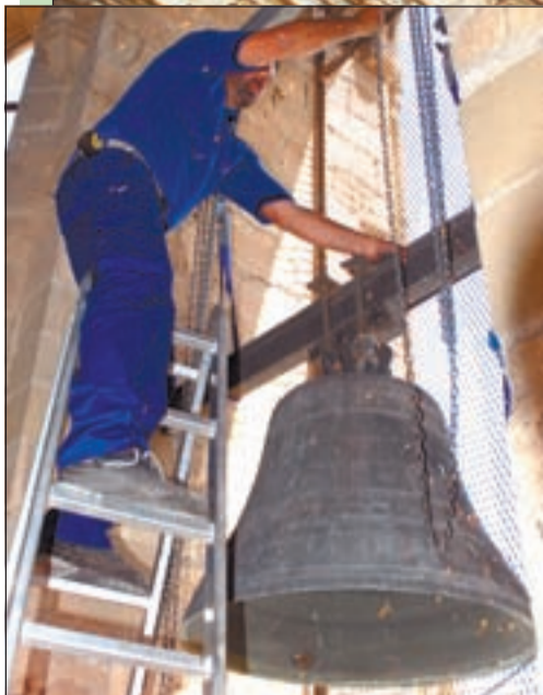
Los operarios trabajaron ayer desde primera hora de la mañana preparando la grúa y la maquinaria necesaria para bajar la campana de 600 kilos. En un mes se trasladará hasta Alemania, en donde se le reparará una grieta que impedía su uso y la ponía en peligro. TONY ALCÁNTARA
